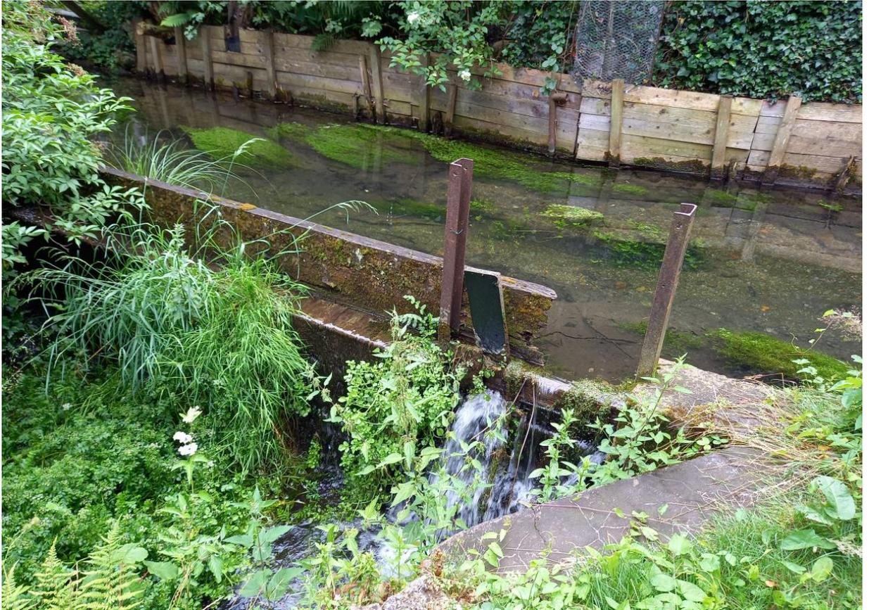
Allein die Höhe des Dammbalkens ist – gemeinsam und abgestimmt auf die o.g. Maßnahmen – hydraulisch zu ermitteln. Sicherzustellen ist ein ständiger Durchfluss mit max. 30 l/s.
