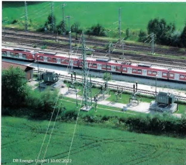
Die zukünftigen Planungen sehen eine Erweiterung des Bahnstromleitungsfelds aus Richtung Markt Schwaben vor. Hierzu wird ein zusätzliches Sammelschienensystem errichtet.
